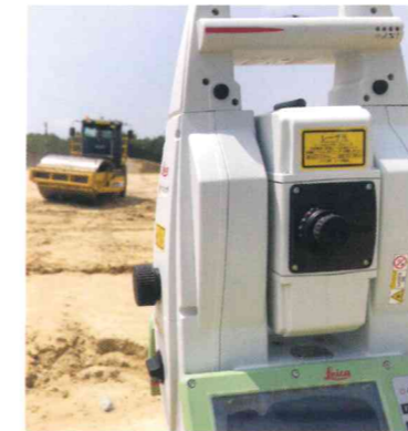
トラッキング計測時の様子 鉄輪中心のプリズム設置
